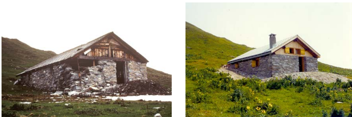
Die Hütte Platt` alva vor und nach der Renovierung
